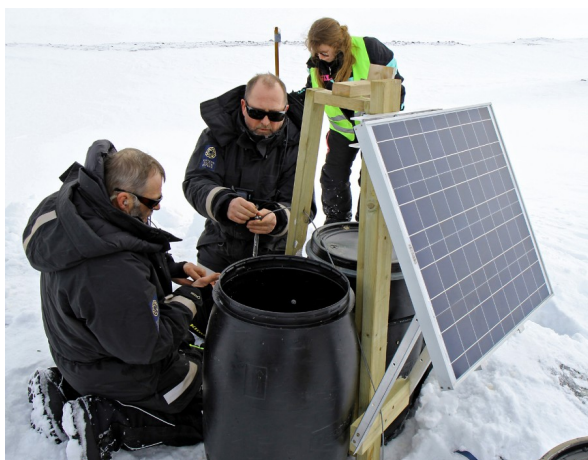
SOLENERGI: Viltkameraet til denne nye føringstasjonen drives av et solcellepanel.
