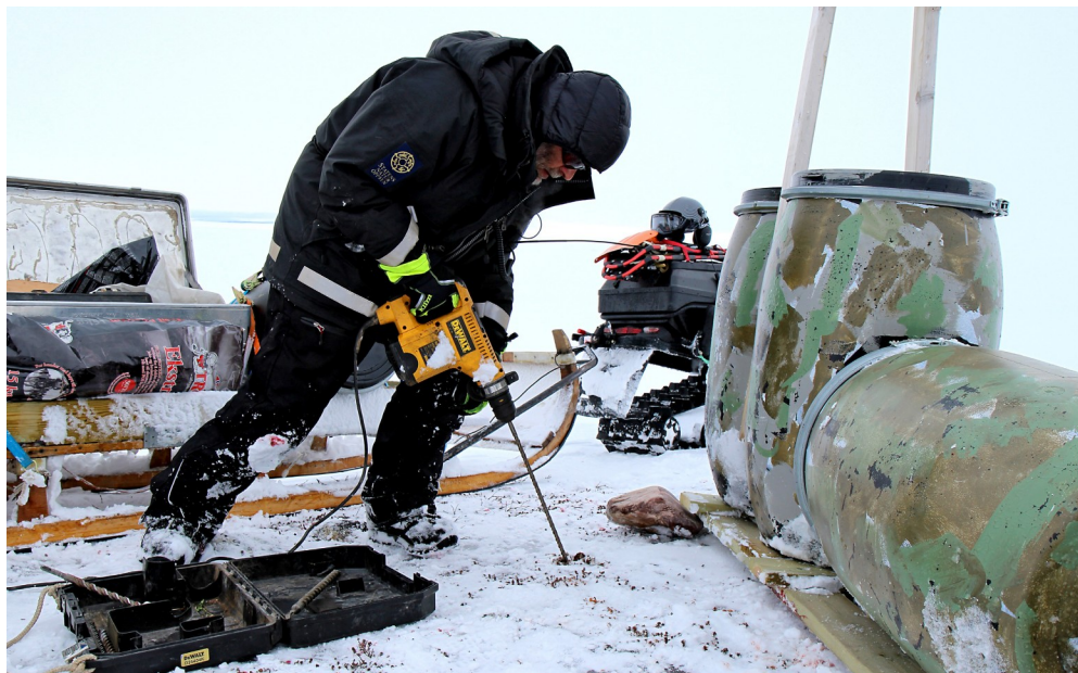
SIKRING: Føringstasjonene på festet skikkelig da værforholdene kan være tøffe. Det medfører boring av hull og armeringsjern ned i bakken der vajerne som holder tønnene fast skal festes.
